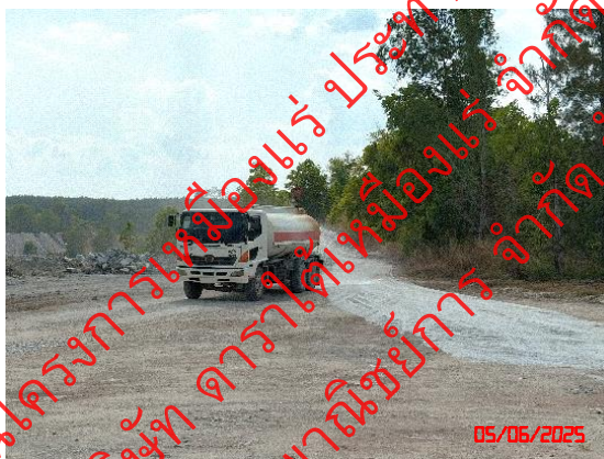
รูปที่ 16 รถฉีดพรมน้ำบริเวณเส้นทางขนส่งแร่
